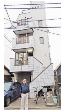
▲1989年に建設した社屋
